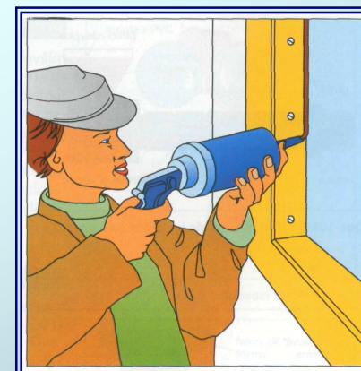
Nanášení silikonové těsnící hmoty
